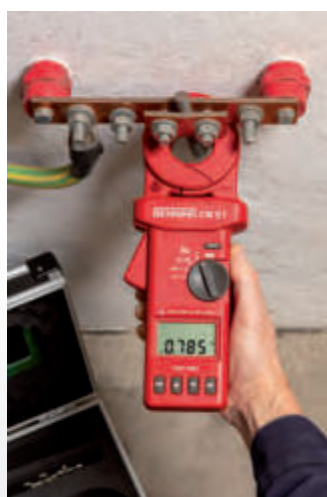
Messung des Erdschleifenwiderstandes eines Anlagenerders
