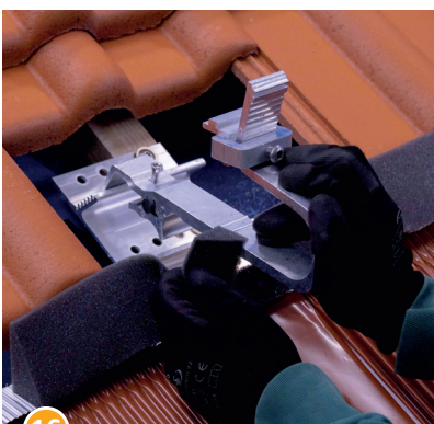
16 Dachhaken in Fuß einhängen.
