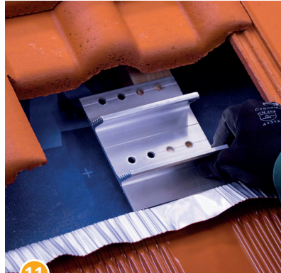
11 Fuß des Dachhakens auf dem Dachsparren ausrichten.
