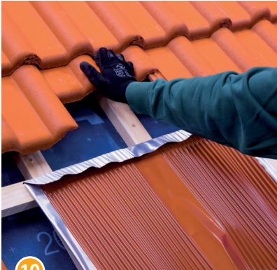
10 Dacheindeckung über Beta-Platte aufdecken.
