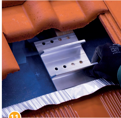
11 Fuß des Dachhakens auf dem Dachsparren ausrichten.
